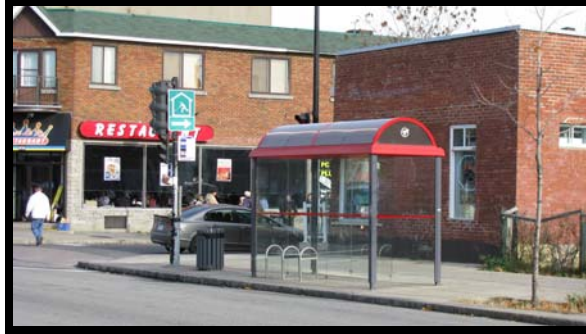
Arrêt d'autobus disposant d'un abribus, d'un banc et d'une poubelle
