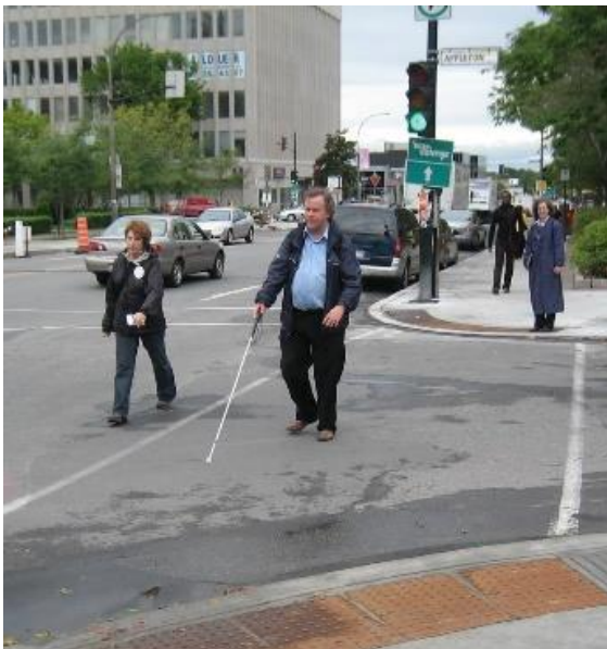
Importance de l'alignement des bateaux pavés pour la traversée de personnes avec déficience visuelle, source : Société Logique
